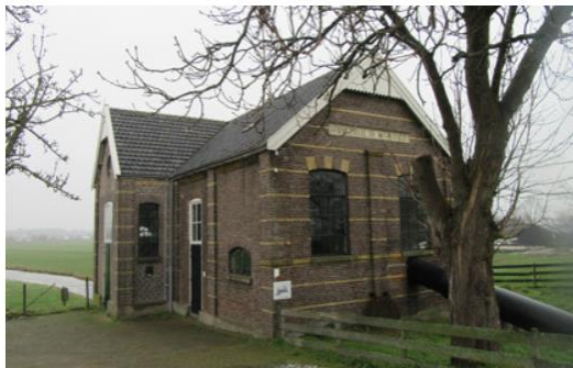
Voorzijde van het gemaalgebouw (2015)
