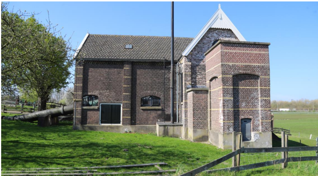
Oostzijde van het gemaalgebouw (2025)
