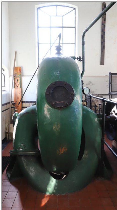
Huidige Stork dubbel aanzuigende centrifugaalwaaierpomp
