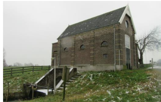
Achterzijde van het gemaalgebouw (2015)
